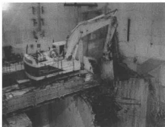
ポークレーンで吊った作業用プラットフォームを用いた原子炉建屋コンクリート構造物の解体
