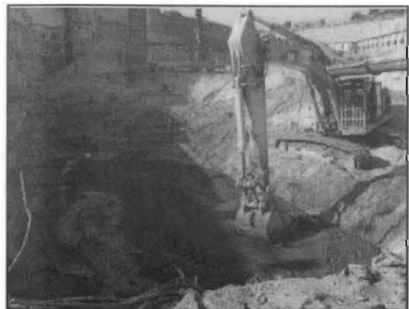
解体跡地の整地
