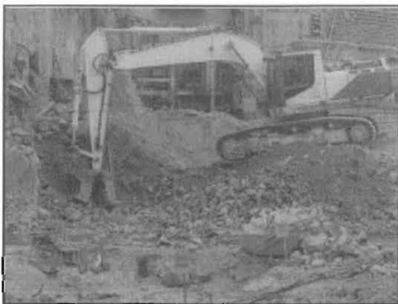
管理棟の解体コンクリートの粉碎
